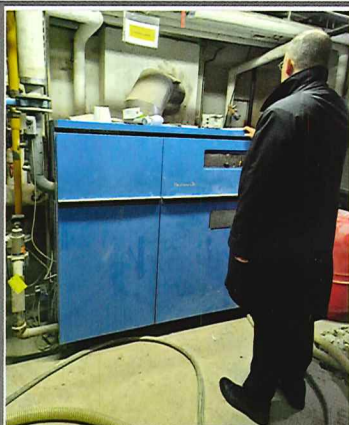
Remplacement de la chaudière 70 000€
